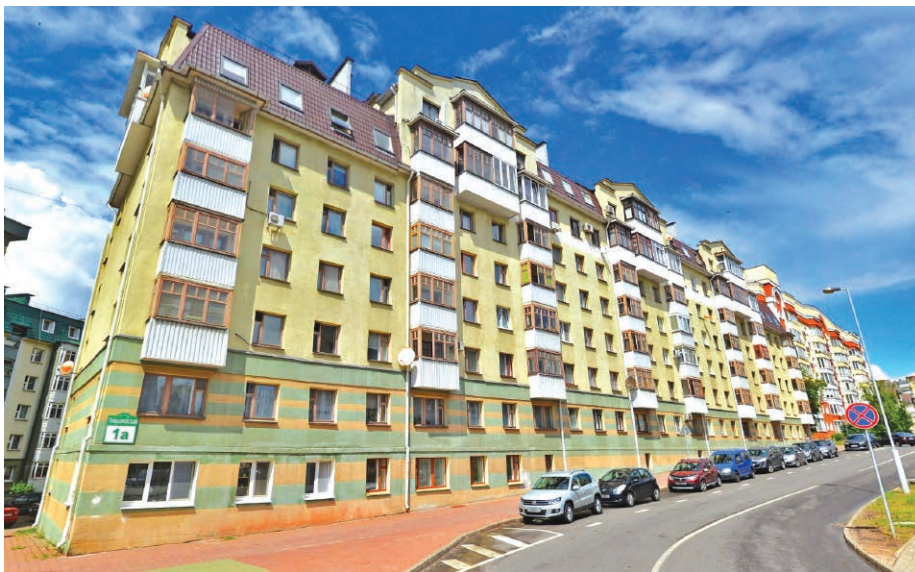
В Минске в доме по ул. Гвардейской, 1А надстроили два этажа, пристроили лифт, заменили инженерные системы, утеплили фасады
